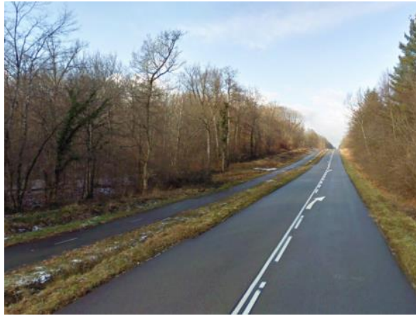
Véloroute Ranchot –Salins-les-Bains dans la forêt de Chaux
