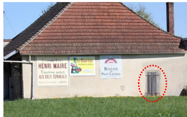
Chamblay – Outre l'infraction surnuméraire, l'apposition de publicités murales sur une façade non aveugle (comportant une ouverture de plus de 0,5 m 2 ) est interdite par le RNP.
