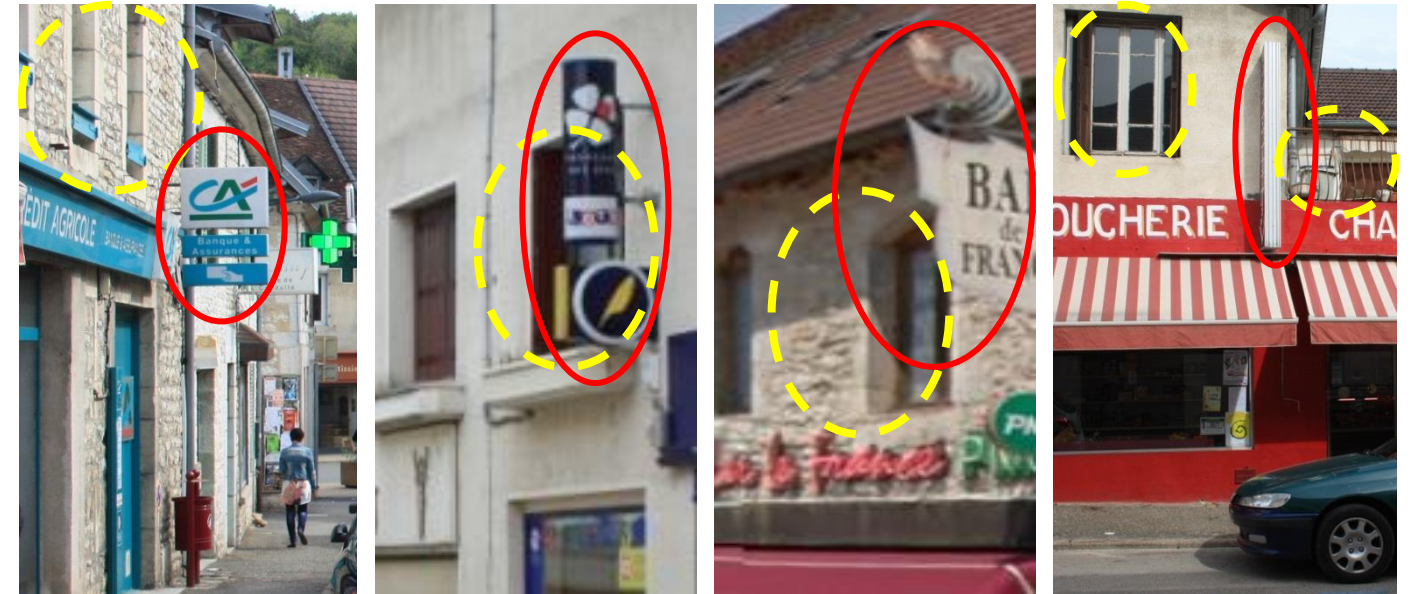
Mouchard – Ces enseignes de façade perpendiculaires au mur (en drapeau) ne sont pas conformes car elles sont apposées complètement ou en partie devant une fenêtre ou un balcon.
