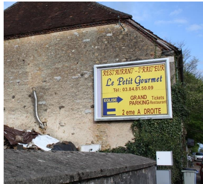
Mont /s Vaudrey – Localisée en centre-bourg, cette préenseigne murale de 5,5 m 2 dépasse les 4 m 2 autorisés hors route à grande circulation, et cumule les indications directionnelles.
