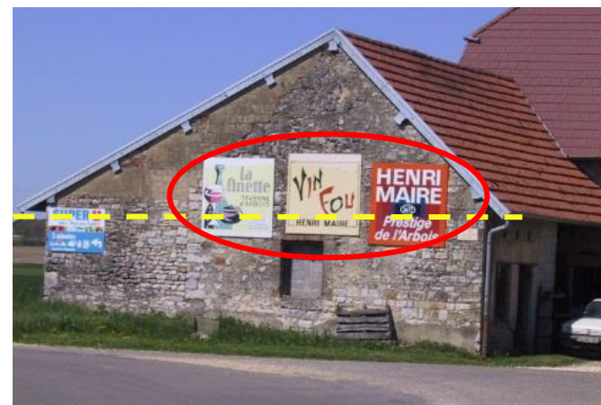
Chissey s/ Loue – Ces publicités murales sont mal positionnées puisqu'elles débordent de la limite des égouts du toit. En outre, elles sont en surnombre par rapport au linéaire foncier (< 80 m = 2 dispositifs muraux superposés).
