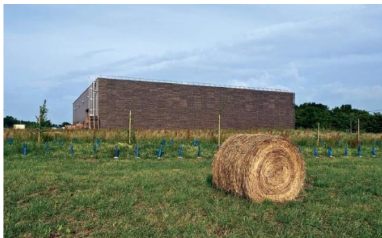
Exemple de bâtiment d'activités présentant une colorimétrie de la façade similaire à celle prévue par le règlement du PLUi
