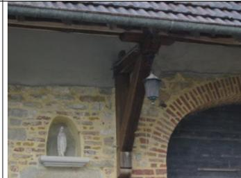
Niche au-dessus de la porte, consoles en bois sous toiture, entourages des ouvertures en brique.
